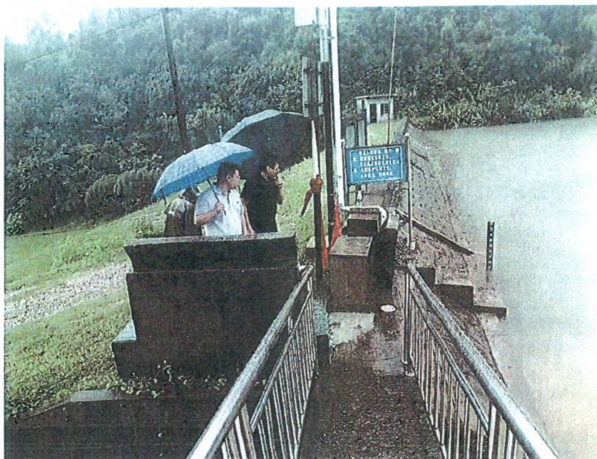
水库取水口周边无隔离防护设施
